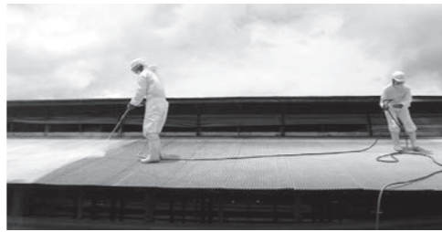
写真2. 屋根へのドロマイト石灰塗布のようす
